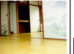
和室の畳をフローリングに変更する際、厚さ12ミリの断熱パネルを敷きました。この時、隙間を止める工夫をしています。
