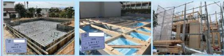
● 基礎土間部の鉄筋を150mm角で組みます。一般的には200mm角ですが、小さく組む方が基礎の強度が違います。
